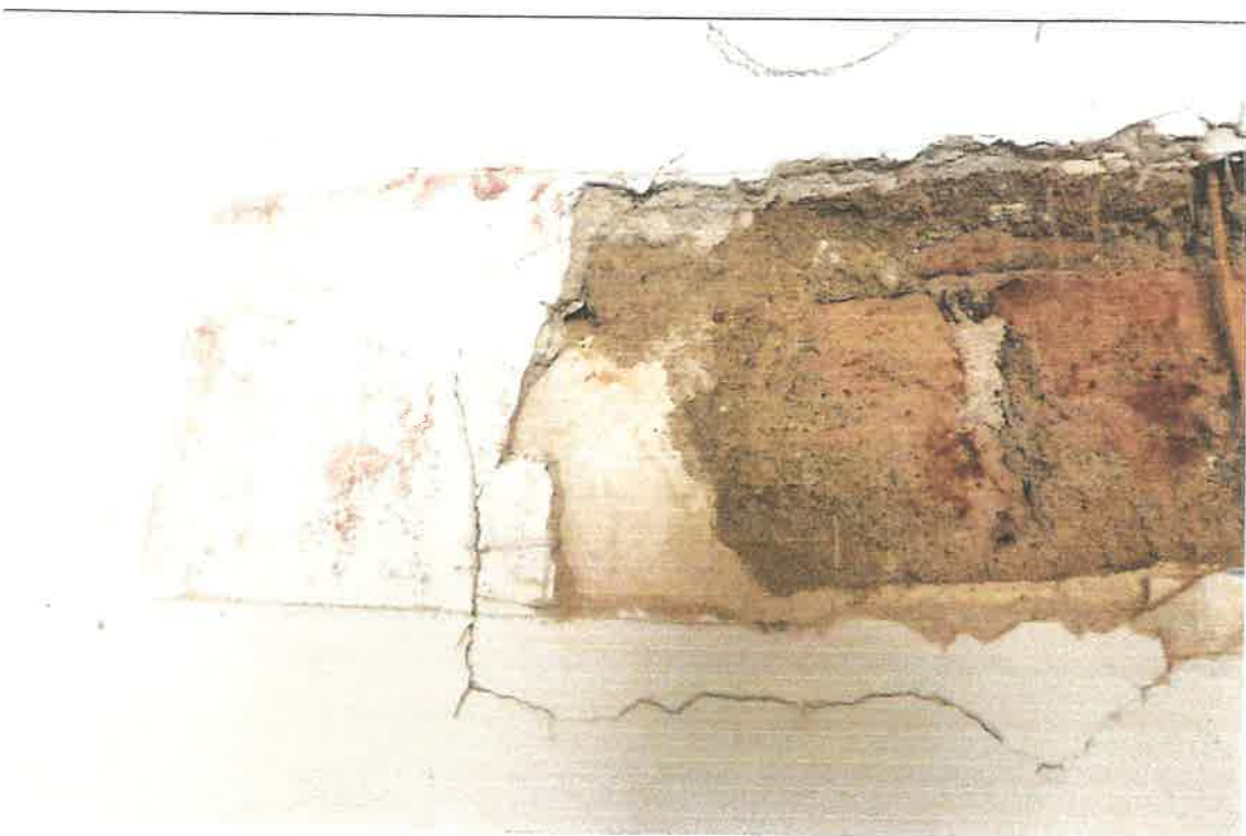
Olomouc, ul. Mlčochova 5, dům (fara). Provedení průzkumu zdiva, omítek a barevnosti na stěnách.. 1NP, místnost 1.13, sonda S7
