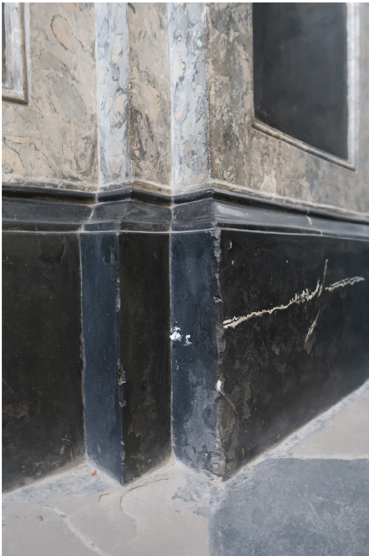
Stav soklové části. Jižní stěna kaple, kde vztlínající vlhkost a zasolení již v minulosti značně poškodila spodní partie umělých mramorů. Dobře jsou vidět mechanická poškození i v minulosti provedené opravy.
