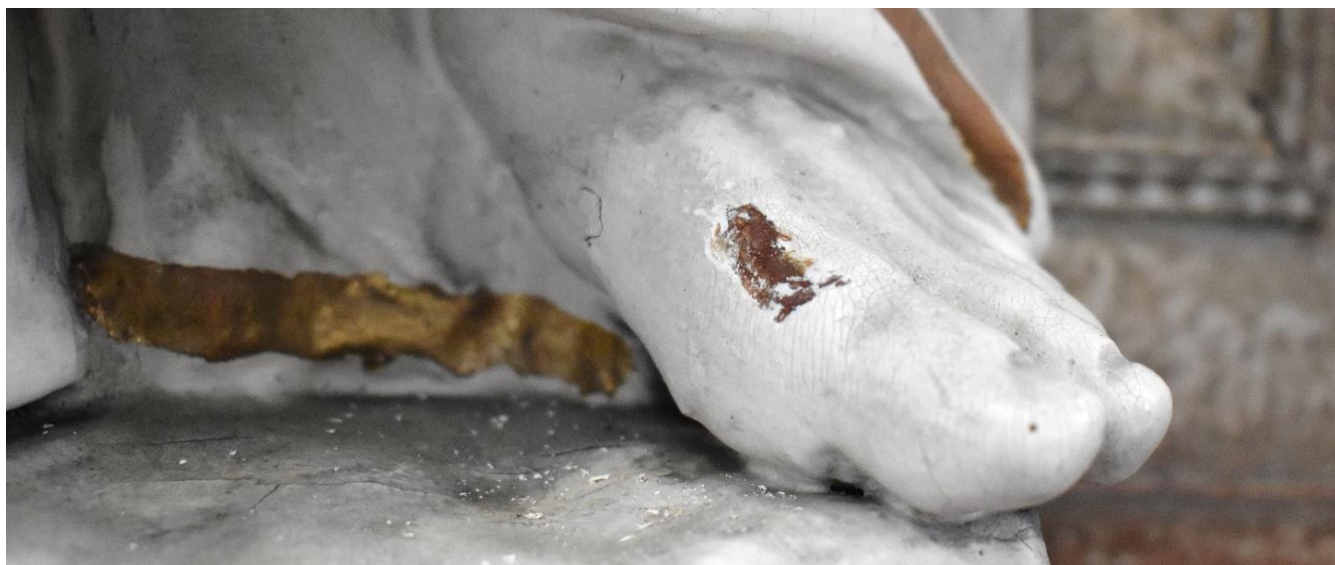
Štarnov, kostel sv. Mikuláše, kazatelna: socha světce (zcela vlevo), malé sondy prokazují s největší pravděpodobností zčernalé stříbro.
