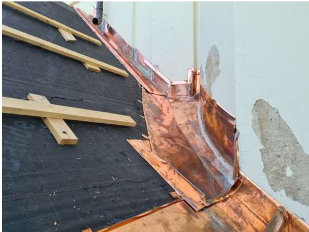
Sakristie - provedení oplechování nástřešního žlabu a úžlabí u hlavní lodi (07/2023)
