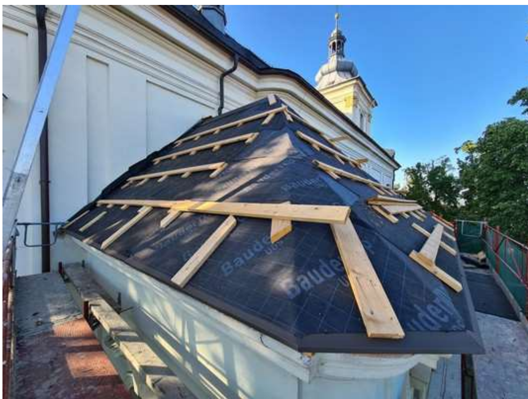
Sakristie - provedení provizorní krytiny z trvanlivé lepenky (07/2023)
