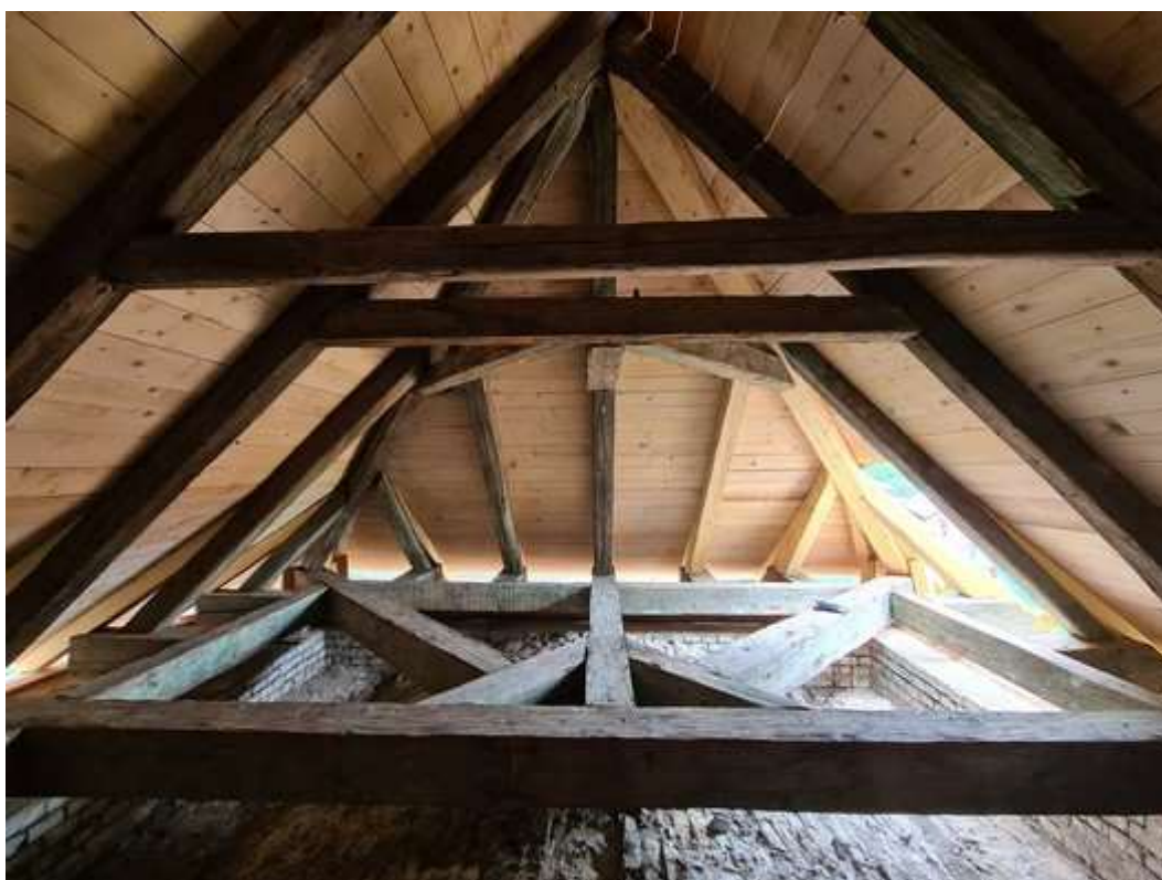
Sakristie - celkový pohled do krovu po provedení výměn a nového bednění (07/2023)
