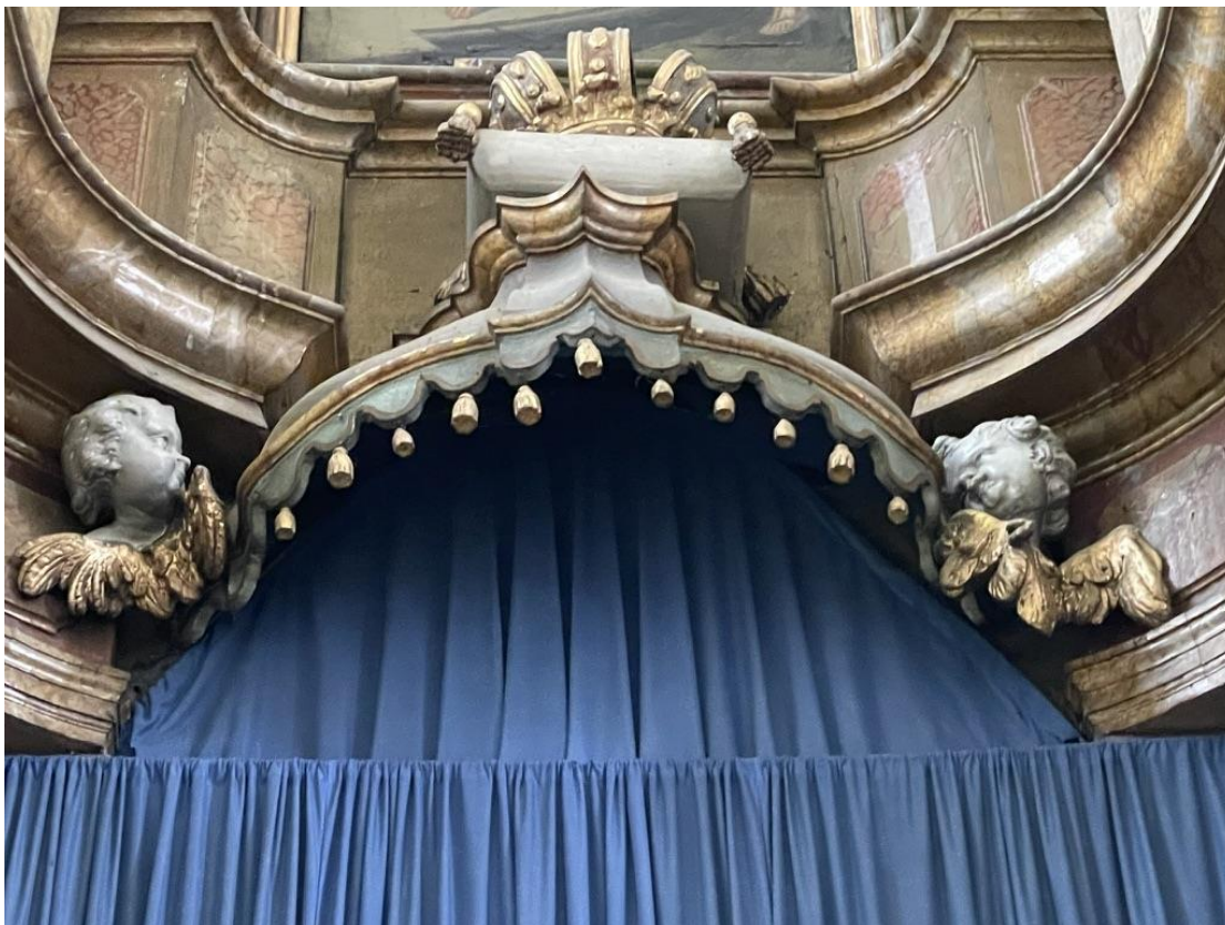
Obr. č. 4 Současný stav oltáře, detail chybějících částí řezeb – draperie pod baldachýnem.
